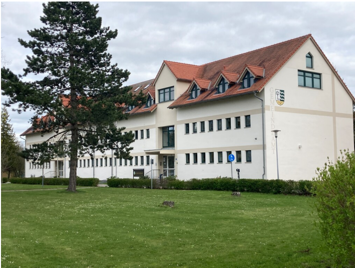
Das ehemalige Kindergartengebäude als Teil der Siedlung Neukieritzsch-Nord, Blick von Westen Fotograf/Urheber: Josephine Dressler
