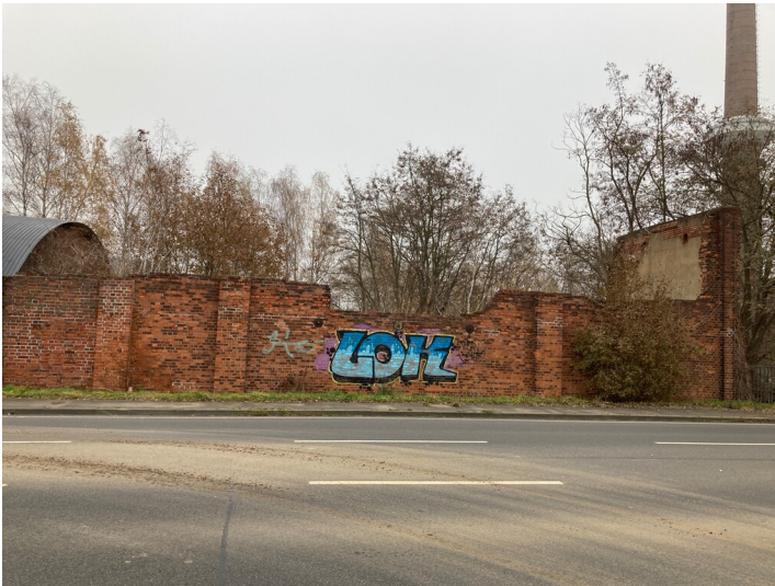
Reste des einstigen Kühlhaus I, Blick von Westen Fotograf/Urheber: Josephine Dressler
