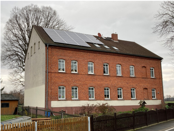
Wohn- und Bürogebäude des einstigen Braunkohlenwerkes Gewerkschaft Graf Moltke, Blick von Südwesten Fotograf/Urheber: Ullrich Ochs
