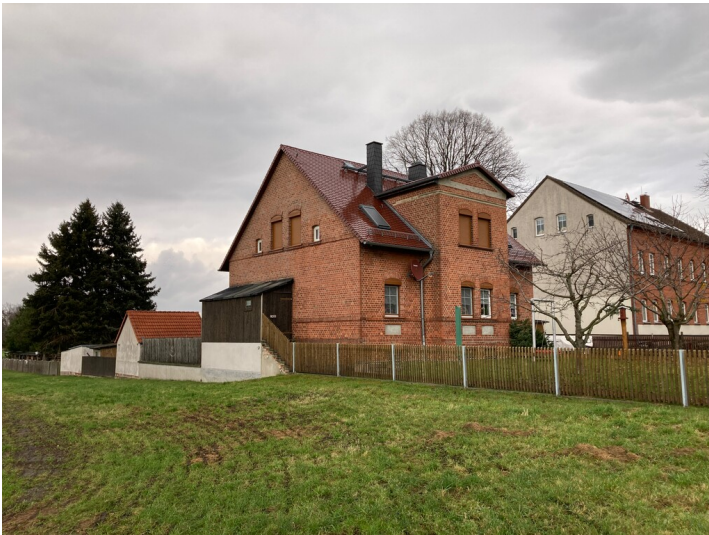
Einstige Direktorenvilla des Braunkohlenwerks Gewerkschaft Graf Moltke, Blick von Südwesten Fotograf/Urheber: Ullrich Ochs
