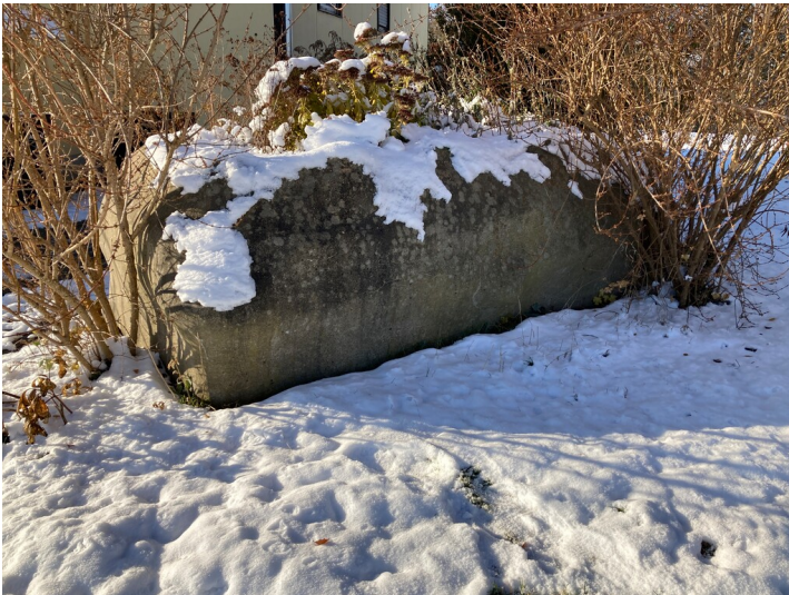
Fundament einer Verladerampe als Teil der Förder- und Transportanlage von Paul Henschel Fotograf/Urheber: Josephine Dressler
