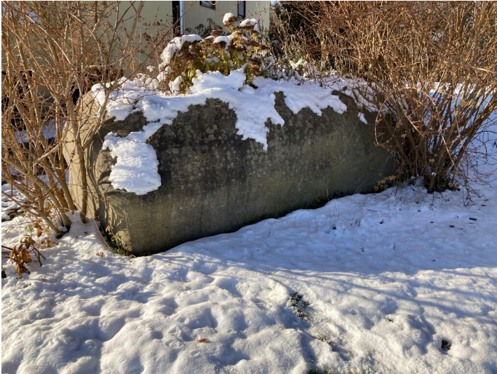
Fundament einer Verladerampe als Teil der Förder- und Transportanlage von Paul Henschel Fotograf/Urheber: Josephine Dressler
