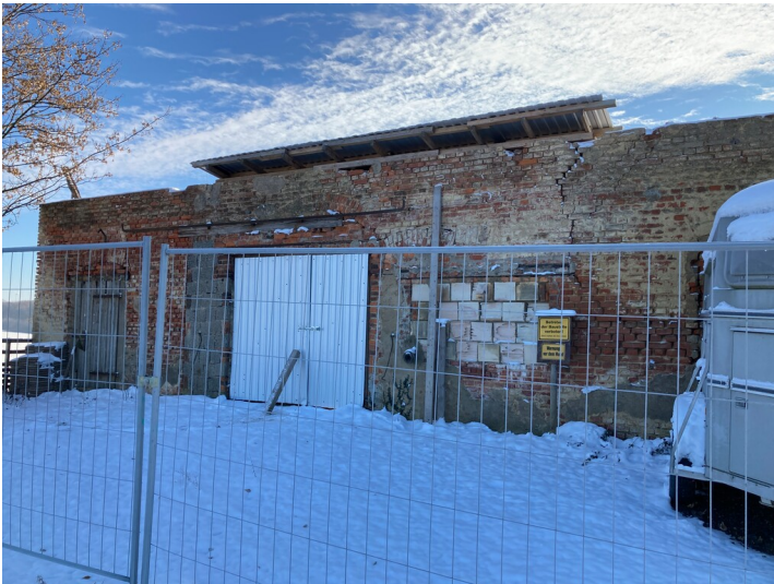
Einziges E-Werk des Braunkohlen- und Tonunternehmens von Robert Henschel, straßenseitige Nordfassade Fotograf/Urheber: Josephine Dressler
