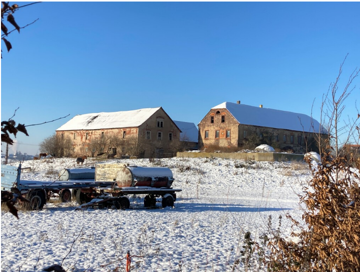
Einstiges Kohlenwerk und Gut Niescher, vormals Roßberg, Blick auf die Kumthalle (links) und das Wohnhaus (rechts) von der Straße im Südosten Fotograf/Urheber: Josephine Dressler
