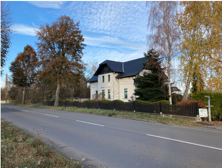
Exemplarischer Blick in Neukirchen an der jüngeren Hauptstraße auf die Villen und die Brikettfabrik im Hintergrund Fotograf/Urheber: Josephine Dressler
