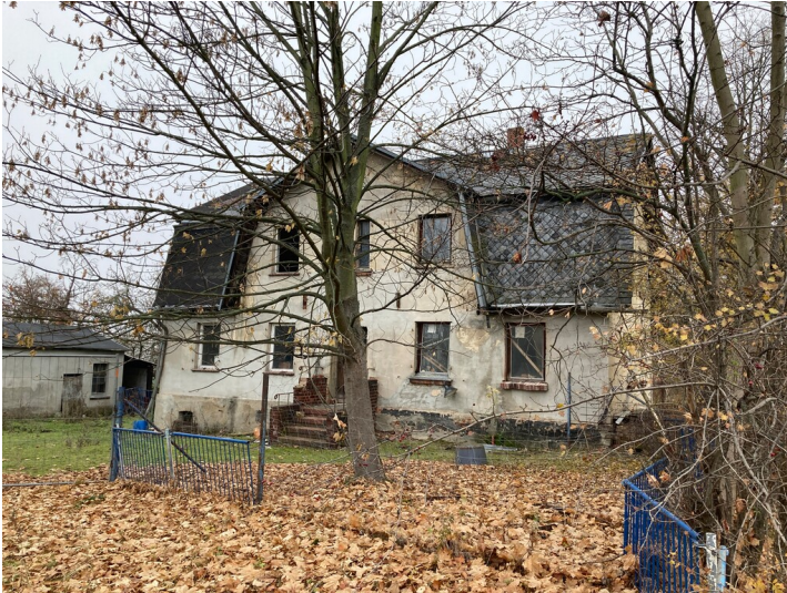
Wohnhaus mit westlichen Nebengebäude, Blick von Süden Fotograf/Urheber: Josephine Dressler
