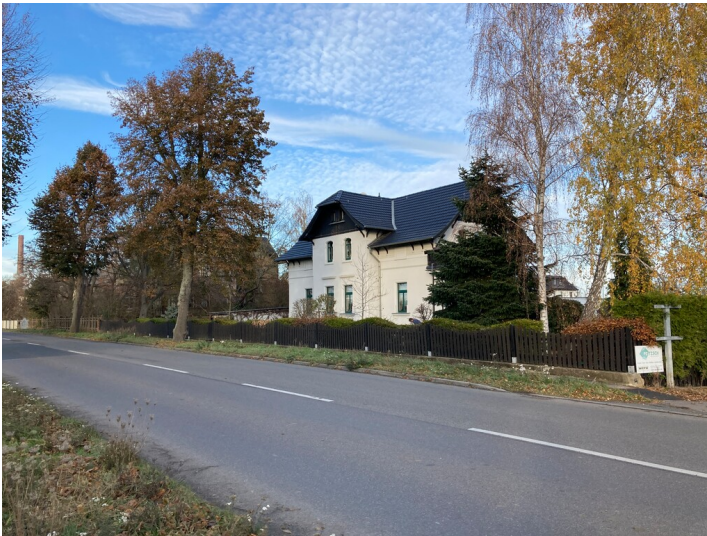
Villen der ehemaligen Braunkohlenwerke und Brikettfabrik Neukirchen-Wyhra, vorn Nr. 25, im Hintergrund der Schornstein der Brikettfabrik Neukirchen, Blick von Südwesten Fotograf/Urheber: Josephine Dressler
