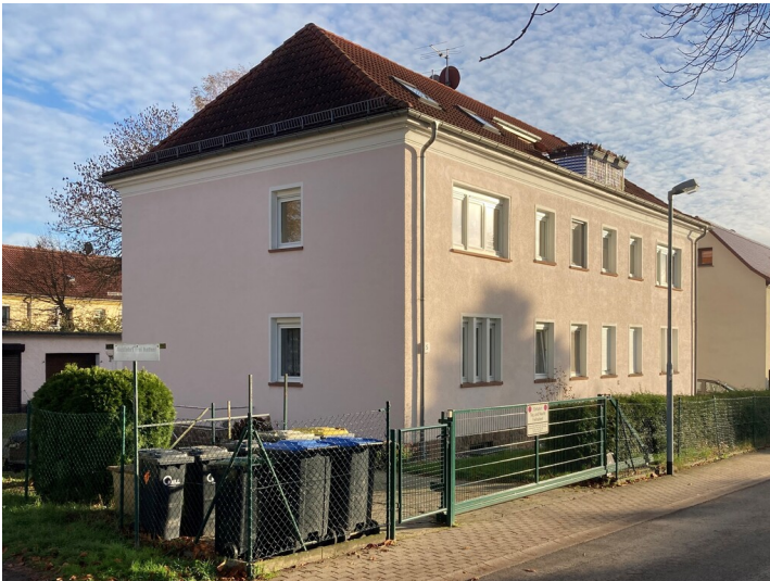
Mehrfamilienhaus, Blick von Nordwest Fotograf/Urheber: Christian Schmidt
