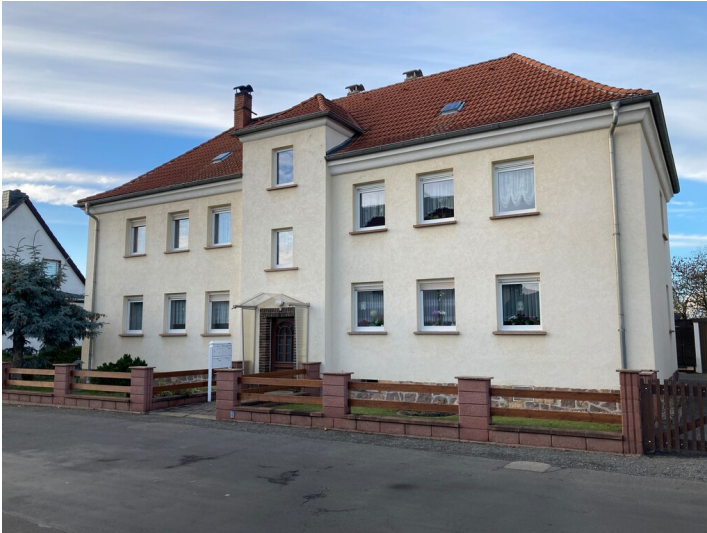
Mehrfamilienwohnhaus der Bergmanns-Wohnstättengesellschaft, Blick von Osten Fotograf/Urheber: Josephine Dressler
