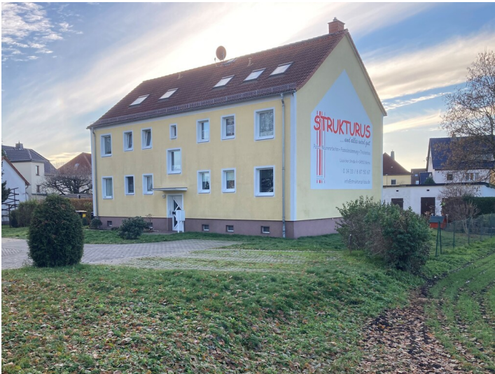
Vierfamilienwohnhaus mit Nebengebäude (rechts im Hintergrund), Blick von Nordosten Fotograf/Urheber: Christian Schmidt
