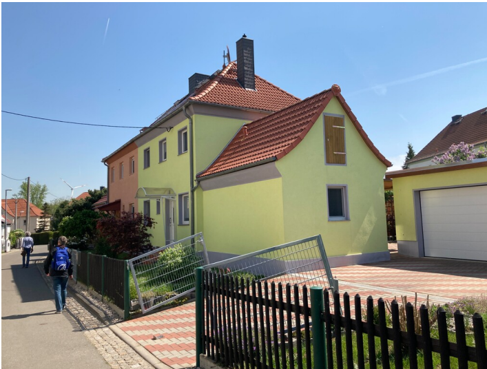
Siedlung der Bergmanns-Wohnstättengesellschaft Meuselwitz-Rositz mbH, Doppelhaus in der Grubenstraße mit seitlich angebautem ehemaligen Stall, Blick von Westen Fotograf/Urheber: Josephine Dressler
