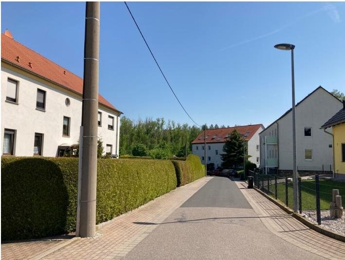
Ersatzwohnungsbau Blumroda in der Glück-Auf-Straße mit Blick von Westen Fotograf/Urheber: Josephine Dressler
