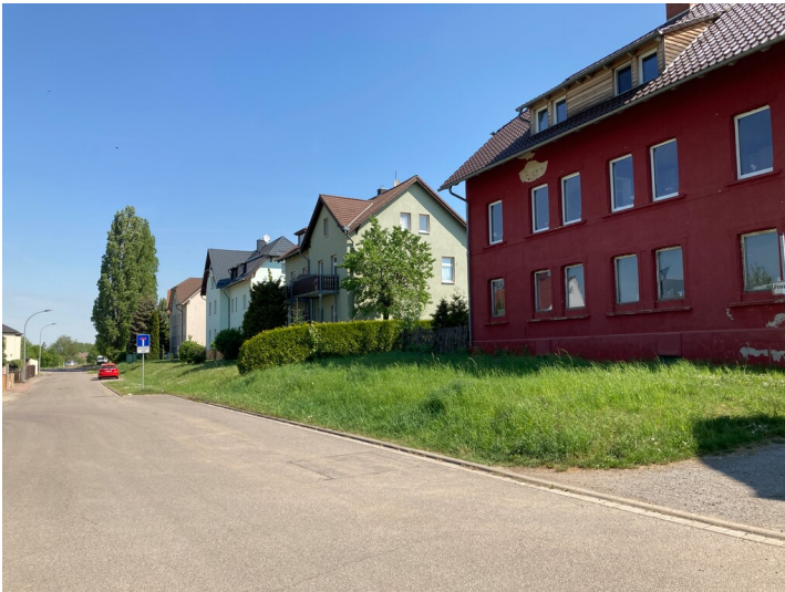
Siedlung an der Leipziger Straße, vorn (rot) das ehemalige Obersteigerhaus, im Hintergrund erhaltene Pappeln Fotograf/Urheber: Josephine Dressler
