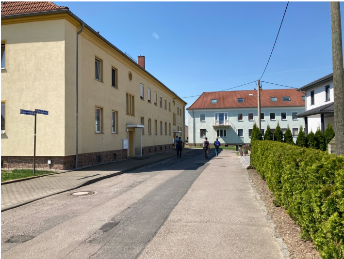
Zwei zweispännige Mehrfamilienhäuser, Blick von Glück-Auf-Straße nach Westen Fotograf/Urheber: Josephine Dressler
