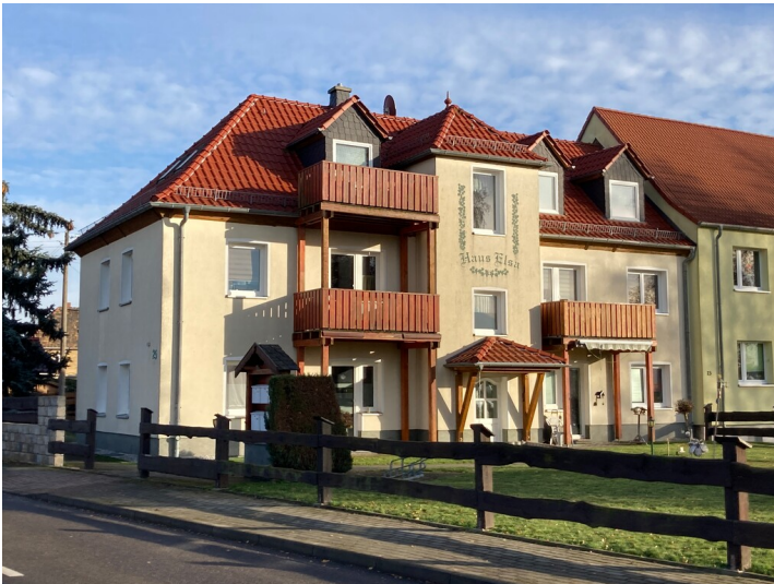
Vierfamilienhaus mit markantem Treppenhaustrisalit, Blick von Nordwesten Fotograf/Urheber: Josephine Dressler
