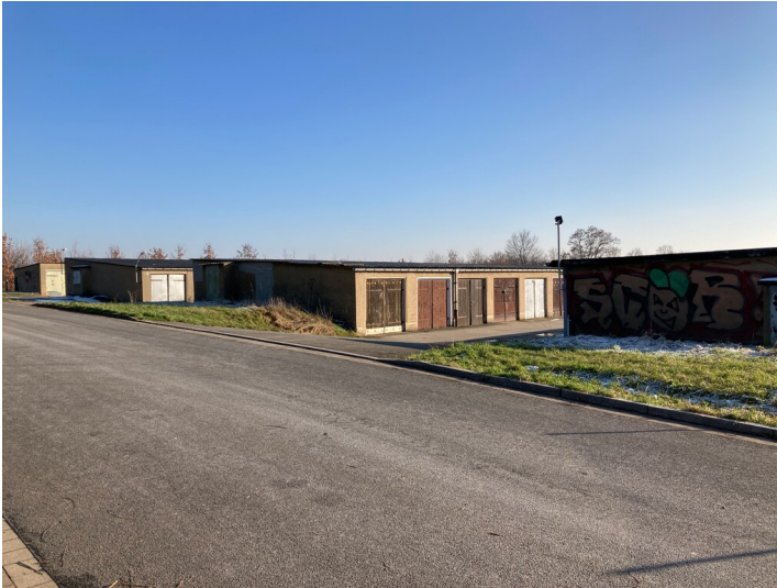
Garagenhöfe der Siedlung Borna-Ost, hier die südöstlichen, Blick von der nördlichen Lausicker Straße Fotograf/Urheber: Josephine Dressler
