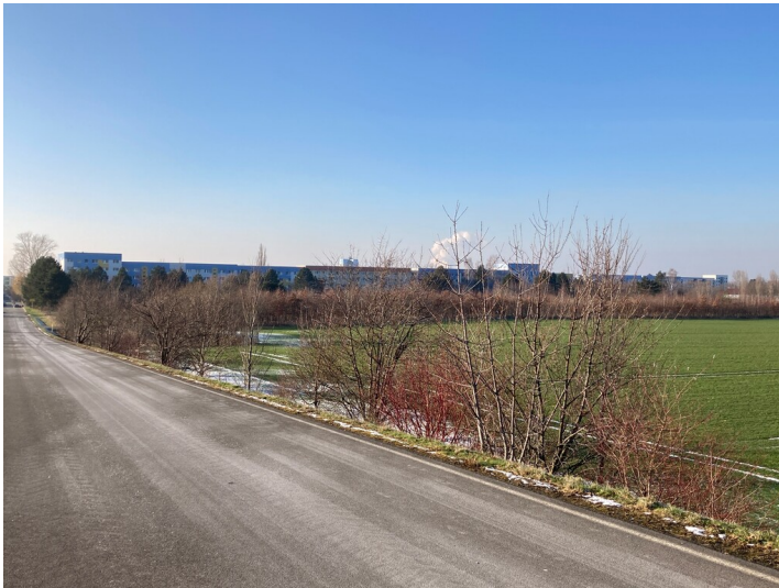
Siedlung Borna-Ost, Blick von der Lausicker Straße im Osten auf die fernwirkungsstarke Front der Wohnblöcke Fotograf/Urheber: Josephine Dressler
