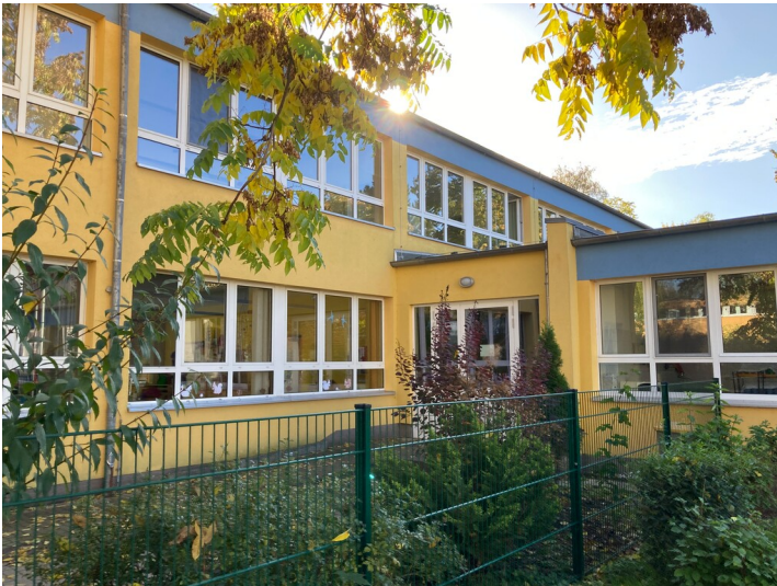
Kindergarten ehemals "20. Jahrestag", Blick auf den zweigeschossigen Hauptbau und den eingeschossigen Wirtschaftsteil, Blick von Nordost Fotograf/Urheber: Josephine Dressler
