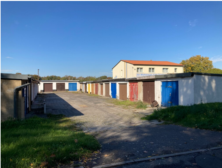
Exemplarischer Garagenhof an der Heinrich-Böll-Straße, als Teil der Siedlung Borna-Nord, Blick von Süden Fotograf/Urheber: Josephine Dressler
