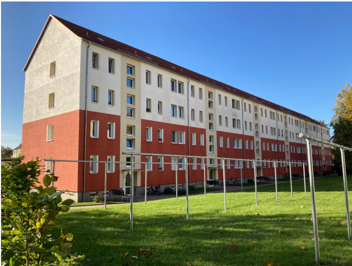
Exemplarischer Wohnblock in der Thomas-Müntzer-Straße der Siedlung Borna-Nord, Blick zu Hausnummer 47 von Südosten, zu den größten Blöcken der Siedlung gehörig Fotograf/Urheber: Josephine Dressler
