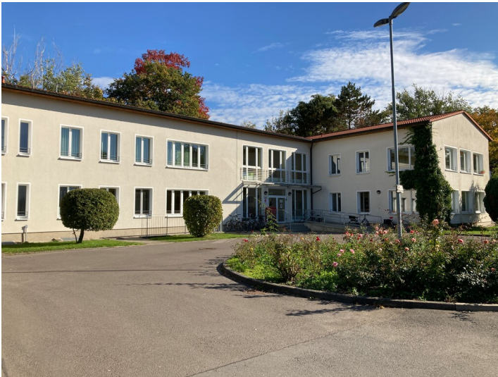
Ehemalige Kinderkrippe »Jenny Marx« in der Siedlung Borna-Nord, Blick von Nordwesten, heute verändert für andere Nutzung Fotograf/Urheber: Josephine Dressler
