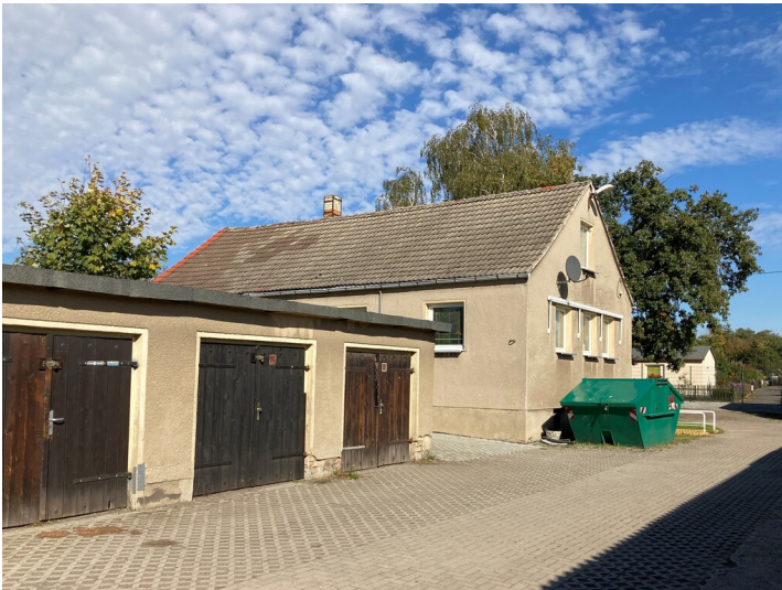
Ehem. AWG-Büro der Siedlung Borna-Nord, neben den später errichteten Garagen, Blick von Südwest Fotograf/Urheber: Josephine Dressler
