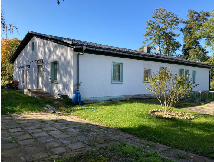
Ehemaliges AWG-Heim der Siedlung Borna-Nord, Blick von Südost Fotograf/Urheber: Josephine Dressler
