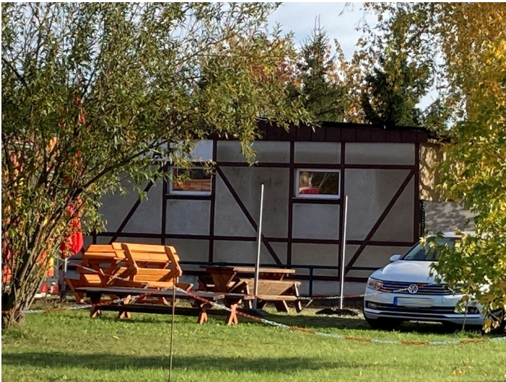
Ehemalige Garage der Tagesanlagen Espenhain in Auenhain, Blick von Norden auf die Fassade mit Scheinfachwerk Fotograf/Urheber: Josephine Dressler
