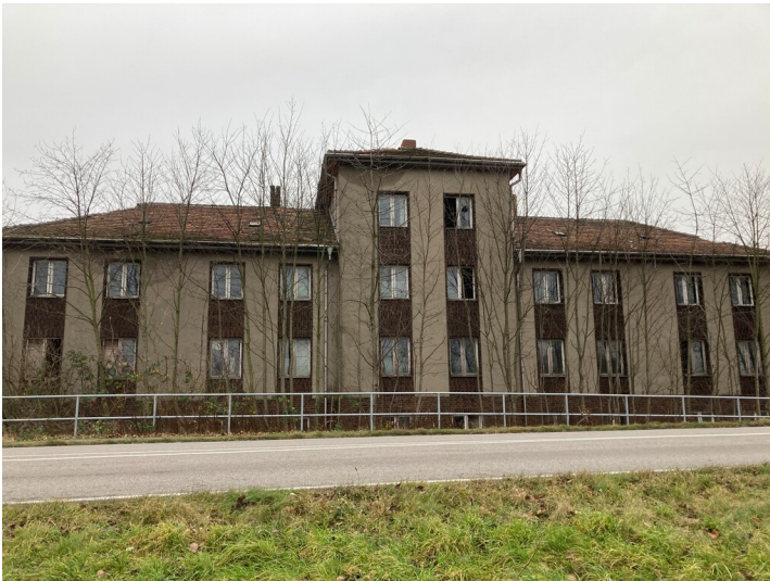
Ledigenwohnheim, Blick von Westen Fotograf/Urheber: Ullrich Ochs
