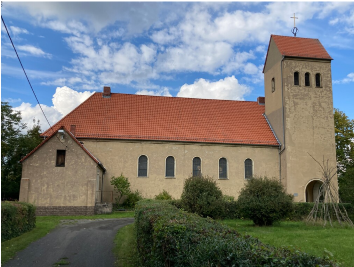
Kath. Kirche St. Konrad, Blick von Süden Fotograf/Urheber: Josephine Dressler
