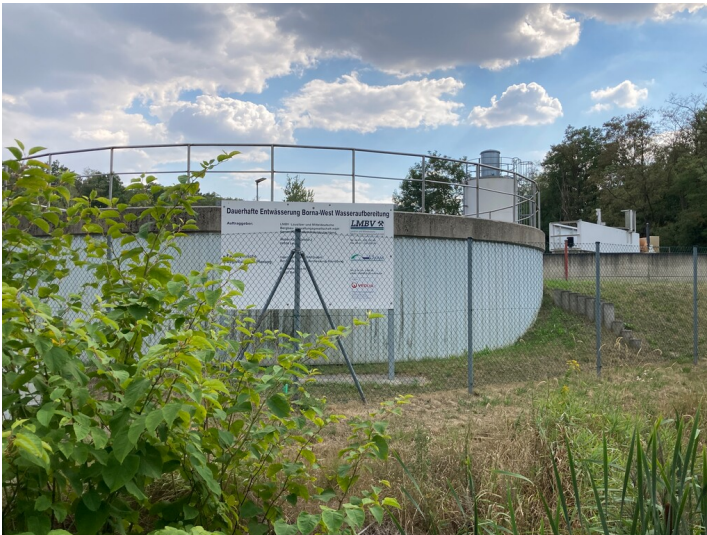
Wasseraufbereitungsanlage straßenseitig mit Informationstafel Fotograf/Urheber: Josephine Dressler
