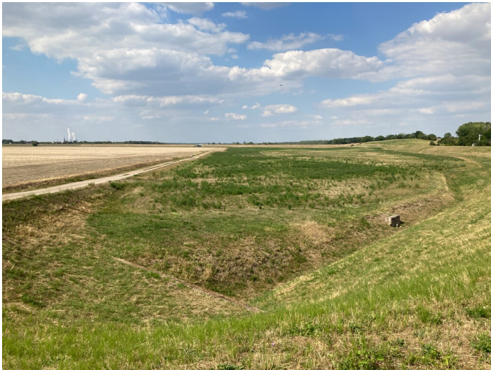
Hochwasserrückhaltebecken Regis-Serbitz mit Erddamm (rechts), Blick von Höhe Thräna nach Norden Fotograf/Urheber: Josephine Dressler
