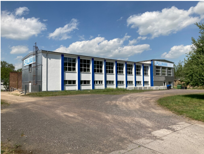
Schaltstation mit Südfügel, Teil der ehemaligen Tagesanlagen, Blick von Südwest Fotograf/Urheber: Nils Schinker
