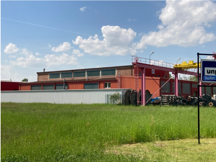
Werkstattgebäude mit vorgelagertem Brückenkran, einst Teil der Tagesanlagen, Blick von Südosten Fotograf/Urheber: Josephine Dressler
