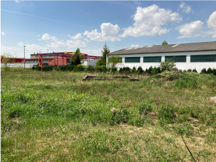
Ehemalige Tagesanlagen Borna-Ost/Bockwitz mit rotem Werkstattgebäude und weißem Speisesaal, Blick von Südost Fotograf/Urheber: Josephine Dressler
