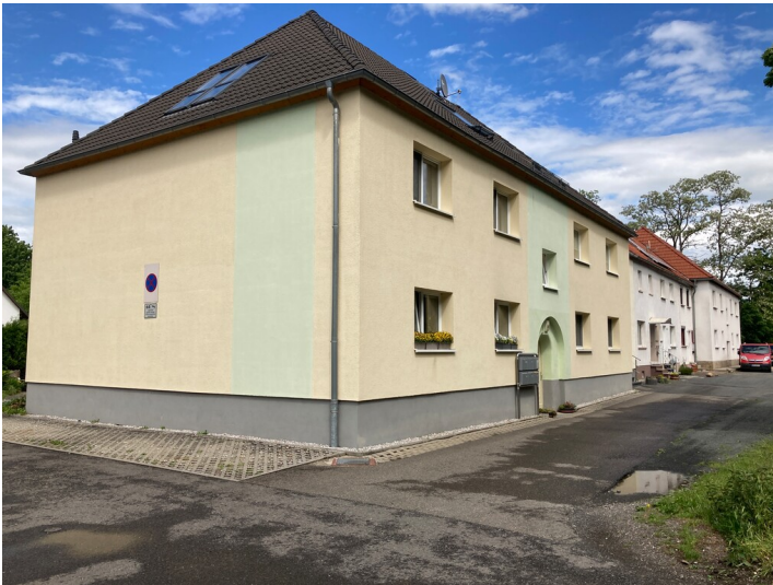
Siedlung nach der Bahnunterführung, hier die südliche Baugruppe von Westen blickend Fotograf/Urheber: Josephine Dressler
