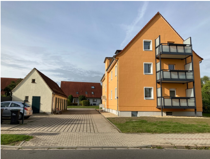
Mehrfamilienwohnhaus mit einstigem Stallgebäude, Blick von Osten Fotograf/Urheber: Josephine Dressler
