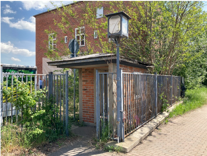
Pförtnerhäuschen mit Teilen der Einfriedung an der Westseite, im Hintergrund das Zechenhaus, Blick von Nordwest Fotograf/Urheber: Josephine Dressler
