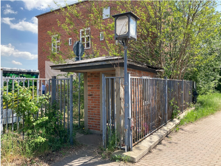
Pförtnerhäuschen mit Teilen der Einfriedung an der Westseite, im Hintergrund das Zechenhaus, Blick von Nordwest Fotograf/Urheber: Josephine Dressler
