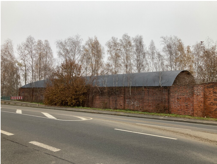
Ehemaliger Brikettstapelschuppen, Blick von Südwesten, davor die S 51 Fotograf/Urheber: Josephine Dressler
