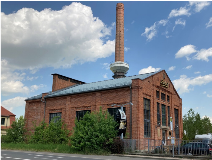
Ehemalige E-Zentrale, Blick von Südwesten und der Straße des Friedens, rechts die Eingangsfassade, im Hintergrund der Schornstein Fotograf/Urheber: Josephine Dressler
