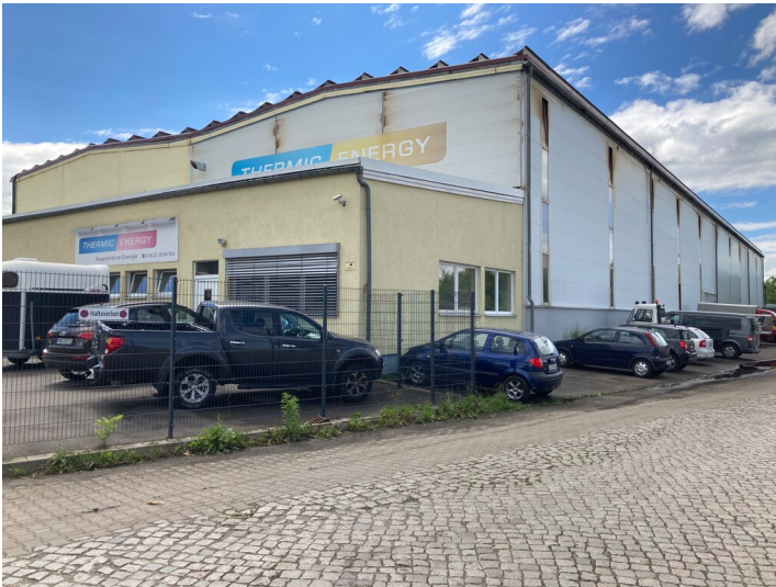
Ehemalige Vulkanisierungswerkstatt des Braunkohlenwerkes Borna, Blick von Osten Fotograf/Urheber: Josephine Dressler
