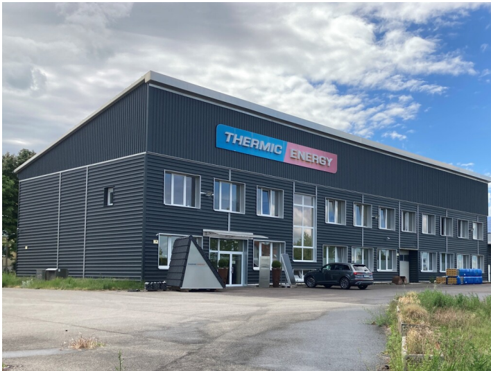
Ehemaliges Rechenzentrum, des Braunkohlenwerkes Borna, Blick von Osten Fotograf/Urheber: Josephine Dressler
