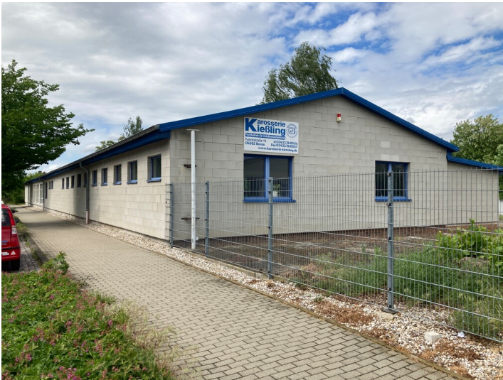
Ehemaliger Fahrradschuppen des Braunkohlenwerks Borna, Blick von Süden Fotograf/Urheber: Josephine Dressler
