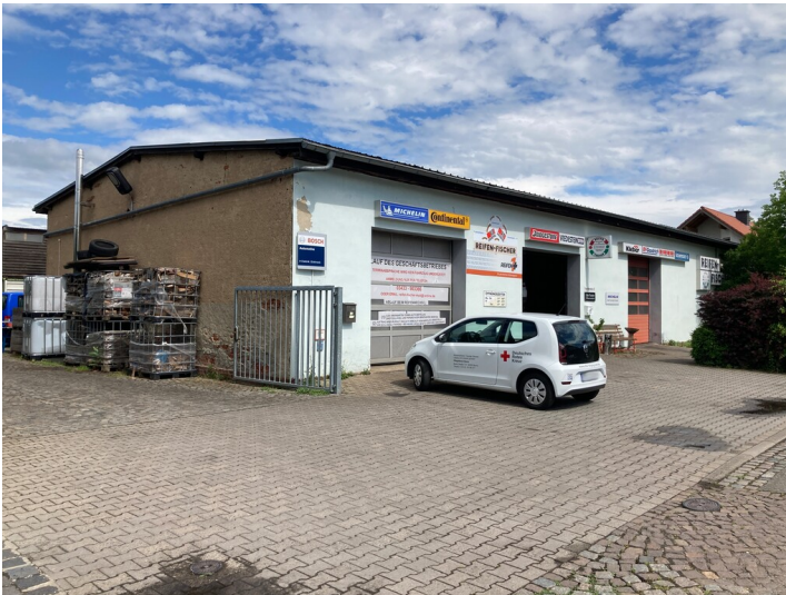
Ehemalige Waschkaue des Braunkohlenwerkes Borna, Blick von Westen Fotograf/Urheber: Josephine Dressler
