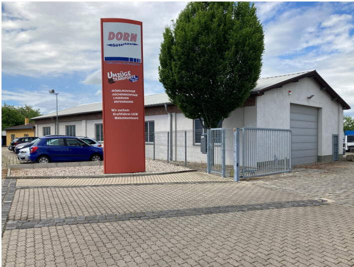
Werkstattgebäude des ehemaligen Braunkohlenwerks Borna (30200046), Blick von Südosten Fotograf/Urheber: Josephine Dressler
