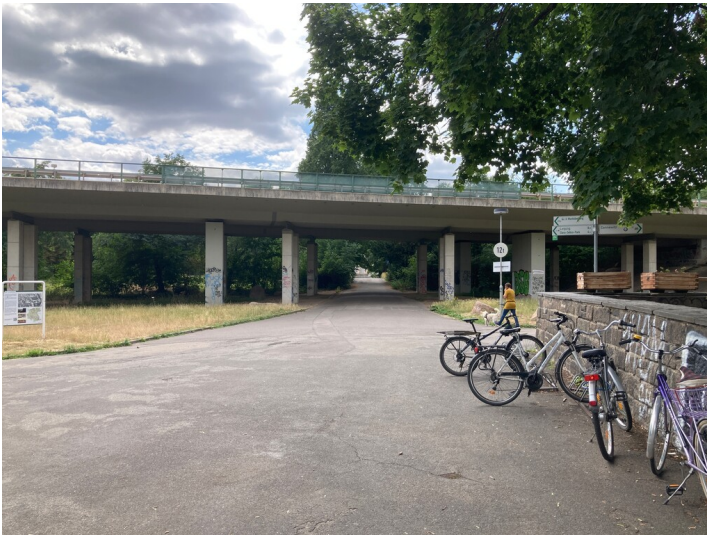
Straßenbrücke im agra-Park und dadurch verstellte Blickachse, hier von Osten zum Weißen Haus Fotograf/Urheber: Josephine Dressler
