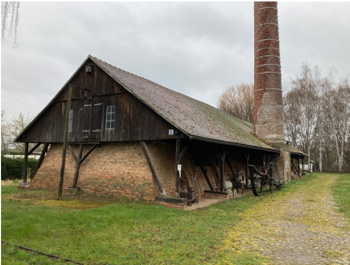
Ehemalige Ziegelei mit gestrecktem Hoffmannschen Ringofen und Schornstein, Blick von Südost Fotograf/Urheber: Josephine Dressler
