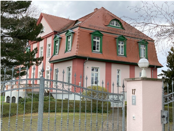
Direktorenvilla, Blick von Zufahrt aus Südosten Fotograf/Urheber: Josephine Dressler
