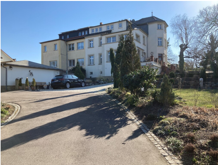
Eines der drei ehemaligen Beamtenwohnhäuser, Blick von Norden Fotograf/Urheber: Josephine Dressler
