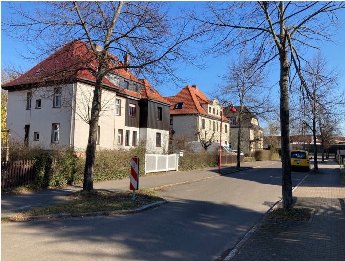
Beamtensiedlung, Blick von Westen auf Nordhälfte Fotograf/Urheber: Josephine Dressler
