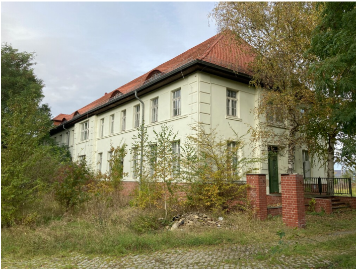
Ehemaliges Verwaltungsgebäude des Braunkohlenwerks Borna, von Fabrikstraße blickend Fotograf/Urheber: Josephine Dressler
